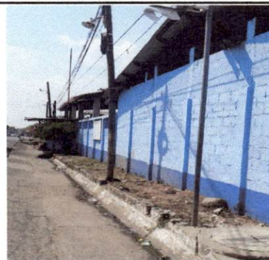
Foto 10: Techos sin canales para agua pluvial, solamente las abrazaderas de canal.
