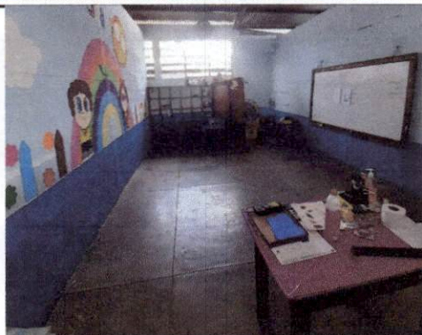
Foto 7: Aula de Nivel Preprimario Etapa 1, piso de torta lisa de cemento.
