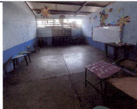
Foto 8: Aula de Nivel Preprimario Etapa 2, piso de torta lisa de cemento.
